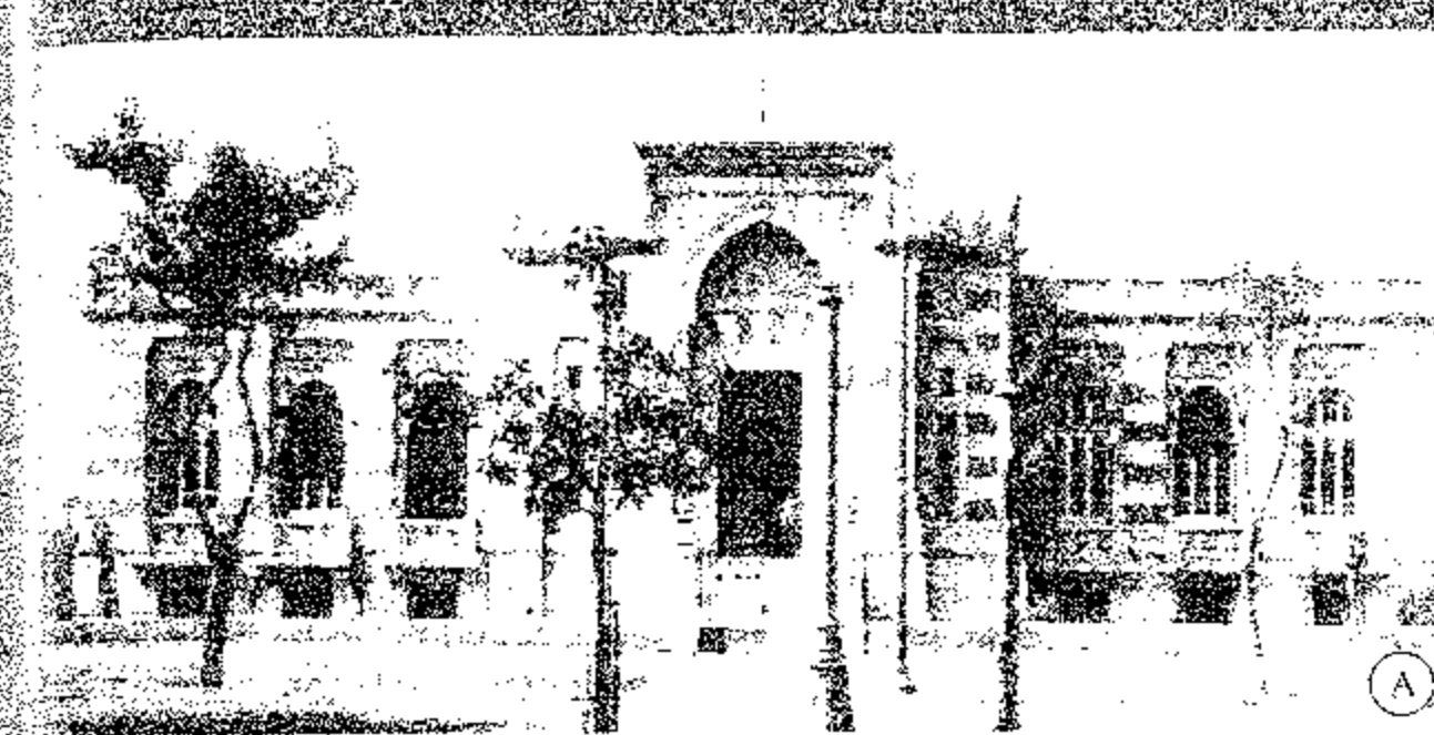
جمعية المهندسين المصرية - ٢٨ شارع رمسيس - وقت إنشائها وقيل إضافة الدور العلوى تصوير عن إصدار كتب الجعد
